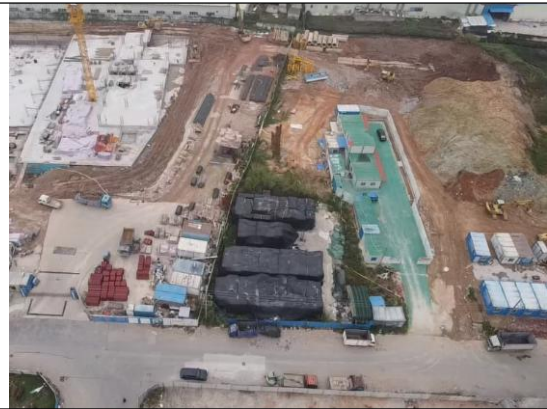
施工场地区、临时堆土区现状
