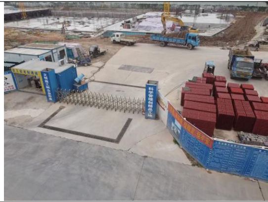
施工出入口现状
