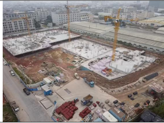
场地建设现状
