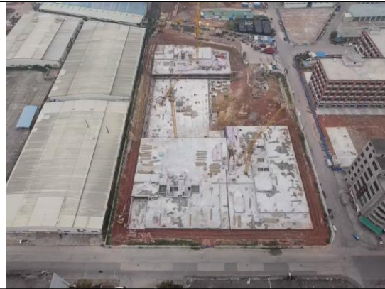
场地建设现状
