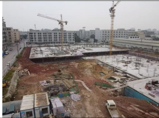
场地建设现状
