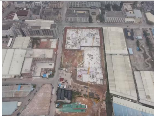
场地建设现状
