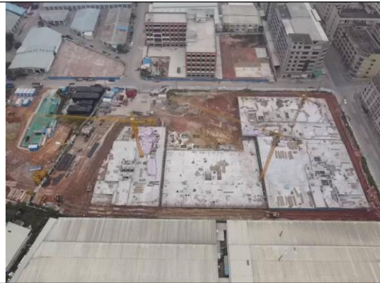
场地建设现状
