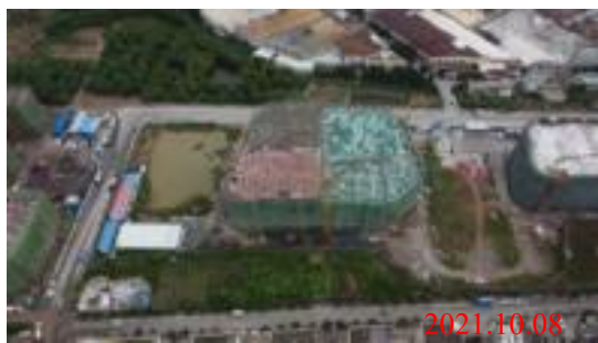
场地建设现状
