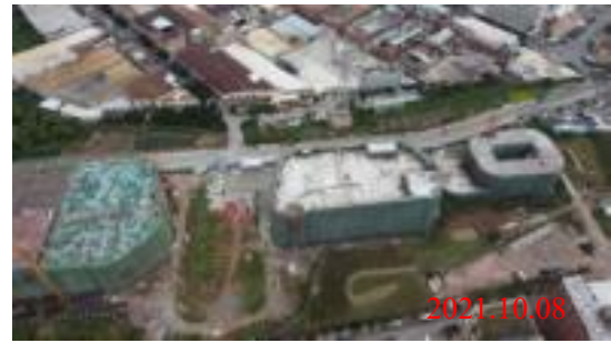
场地建设现状
