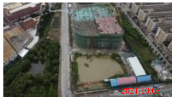
场地建设现状
